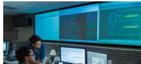
保守が大変な機器のリモートメンテナンスやリモートメンテナンスが必要な機器群
