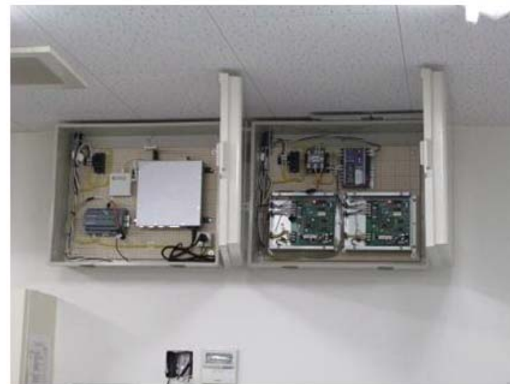
制御盤設置状況 ①
