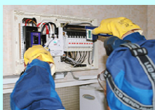
電気設備の安全調査
