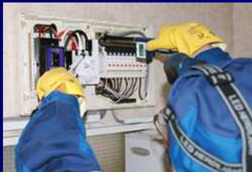
電気設備の安全調査
